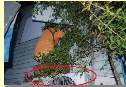
▶ Compressor แอร์ ควรติดตั้ง ให้ห่างจากหน้าต่าง (คนร้ายอาจใช้เหยียบป็นเข้าบ้านได้)
